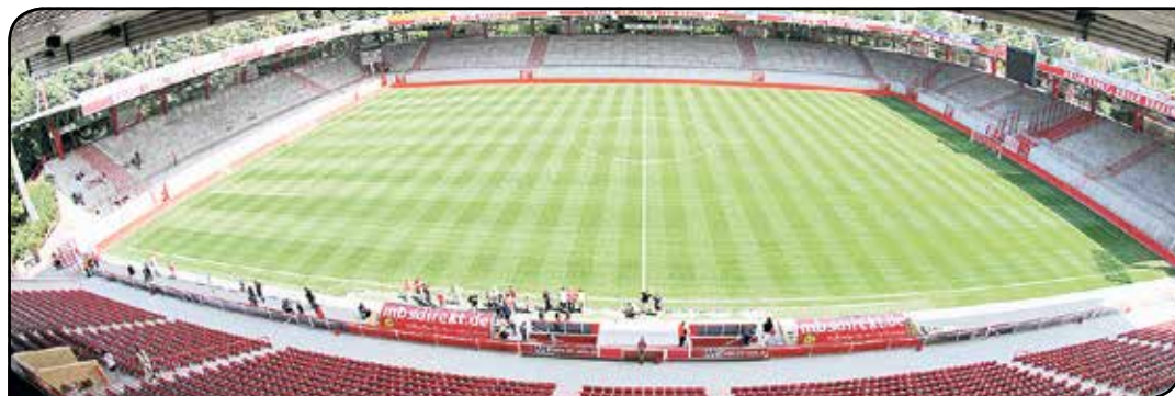
Das Stadion „An der Alten Försterei“ hat den Begriff „Schmuckkästchen“ durchaus verdient.
